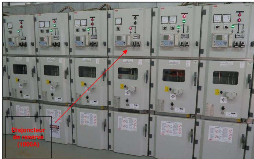
Figure 41: Tableau de génération de la Mine avec disjoncteur de réserve
